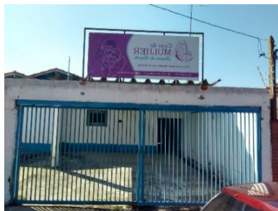
Fachada da Instituição
