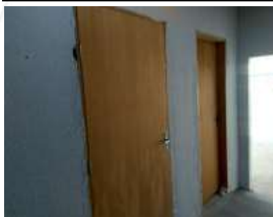
Banheiro em Construção
