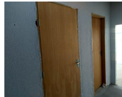
Banheiro em Construção
