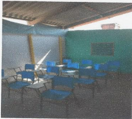
Área Externa Coberta
